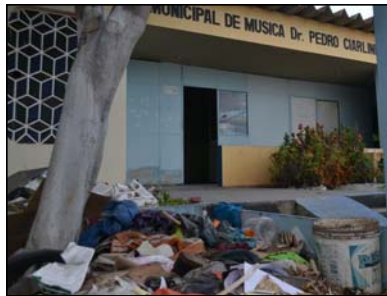
Prédio está abandonado
